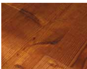
ARIŠ PATINIRAN OŠTEĆENI RUBOVI
